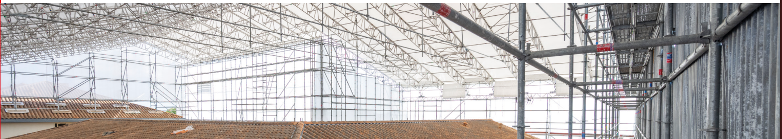
Chantier Metrix avec parapluie ALTRIX - Client FL SERVICES
