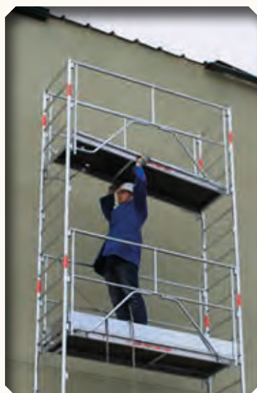
3. Mise en place du plancher
