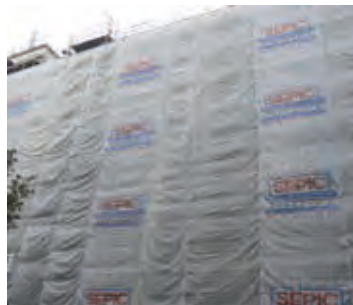
Chantier de la Poste - Rouen (76)
