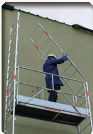
1. Mise en place des échelles
