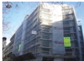
Chantier à Paris (75)
