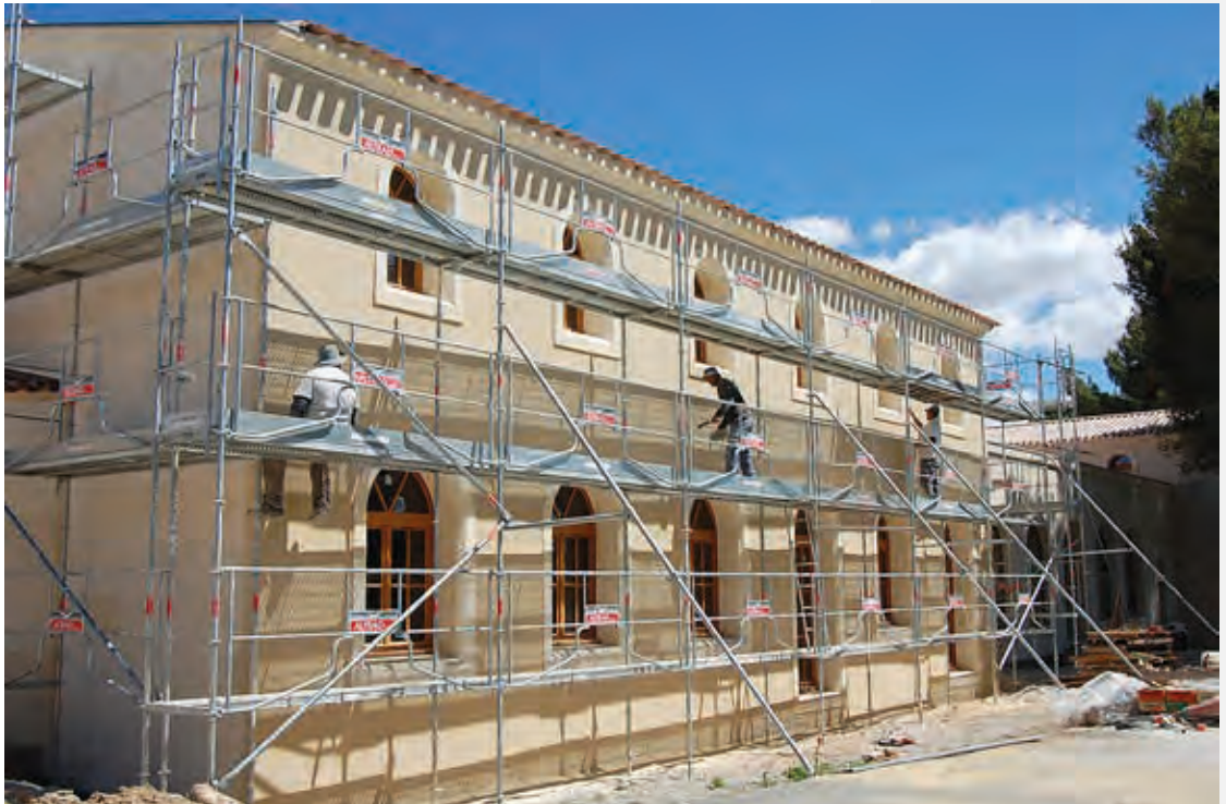
Chantier de façade
