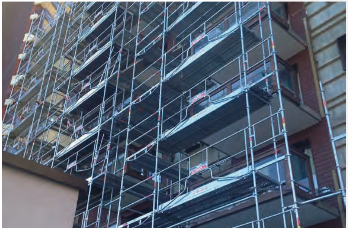
Chantier de façade
