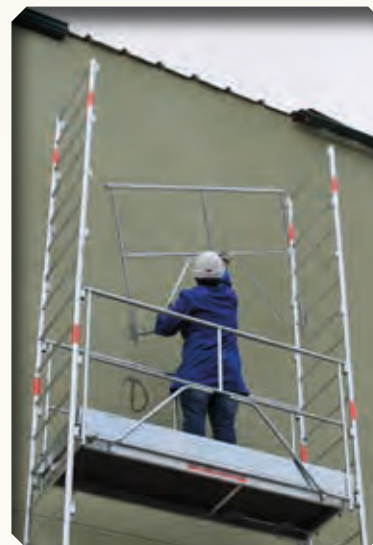
2. Mise en place des garde-corps
